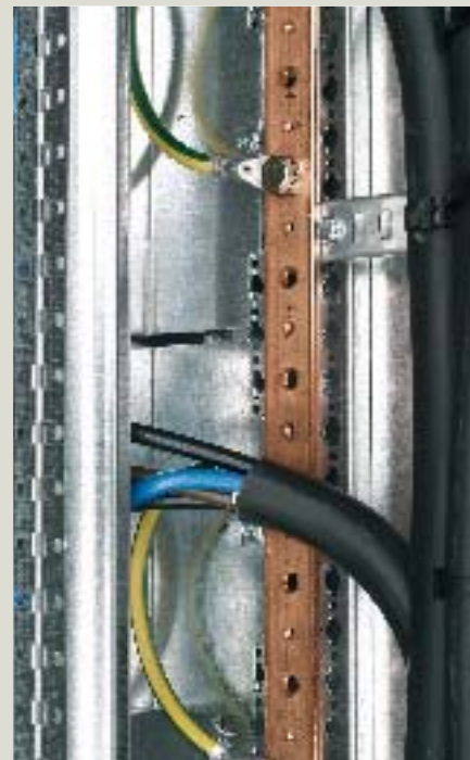
Borne principale en gaine à câbles constituée d'une barre cuivre 32 x 5 mm
