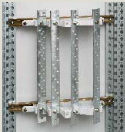
Fixer le répartiteur sur les rails à l'aide des écrous-marteaux réf. 367 60.
