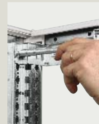
... puis fixer par une seule vis M6 x 10
