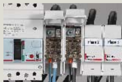
Fixer le répartiteur sur les rails à l'aide des écrous-marteaux réf. 367 60.
