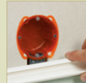
Vérification du positionnement de la boîte et de la moulure
